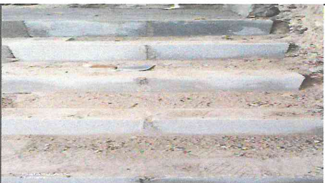
Foto 3: Fundicion de gradas.
