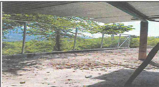
Foto 1: Terminacion de muro perimetral
