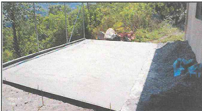
Foto: Terminacion de torta de cemento
